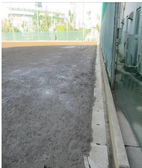
グラウンド側溝清掃
