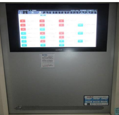
冷暖房装置の制御盤を 改修
