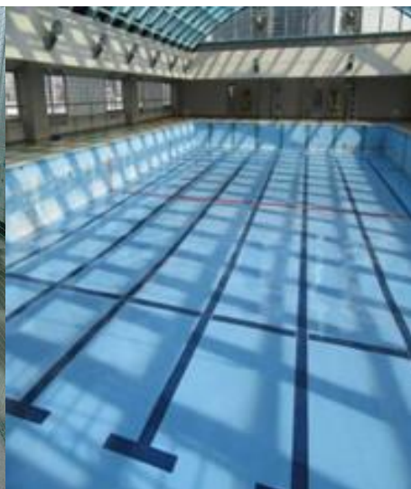
プール底面再塗装
