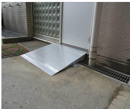
体育館棟出入口口踏み台 金属製に交換
